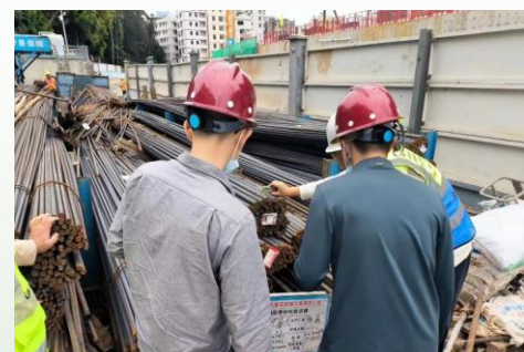
成本部现场检查钢筋材料
