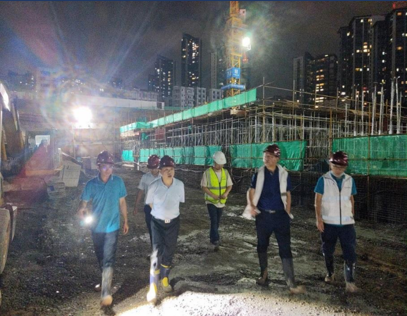
夜间施工巡查
