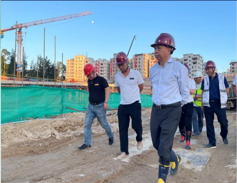
日间施工巡查
