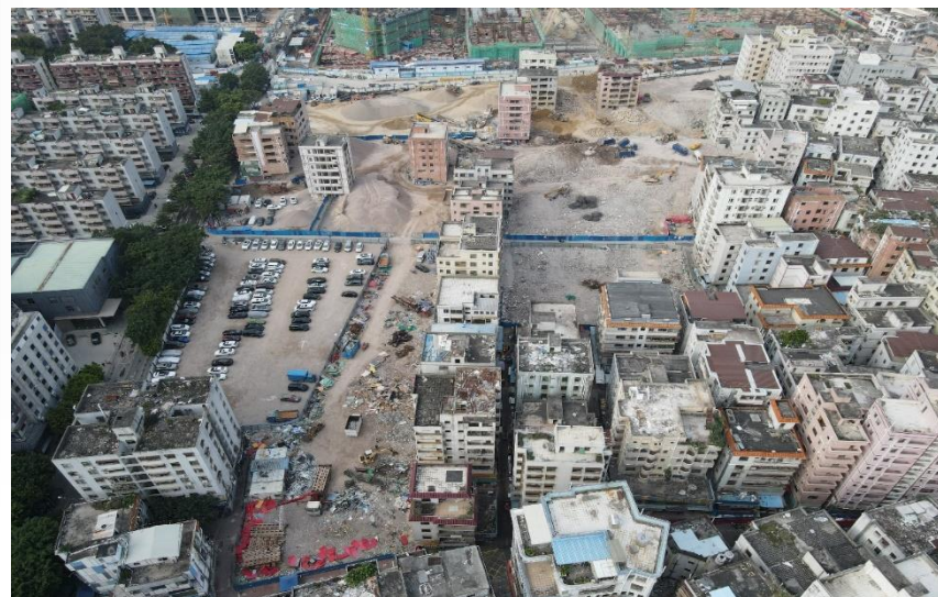
三、四期村拆除完成过半
